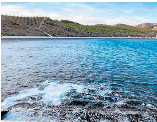
Balsa de aguas regeneradas de La Crujía en Vélez-Málaga. E. C.
