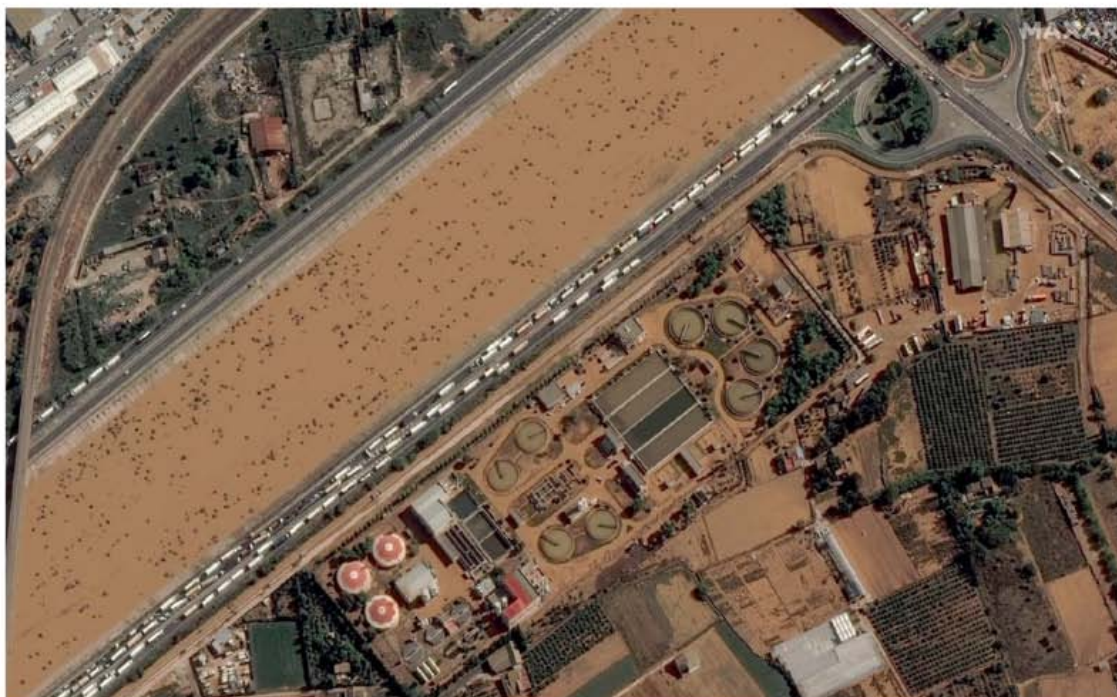
Imagen tomada por satélite de una de las plantas de tratamiento de aguas ubicada en la autovía V30 de Valencia. MAXAR TECHNOLOGIES HANDOUT (EFE)
