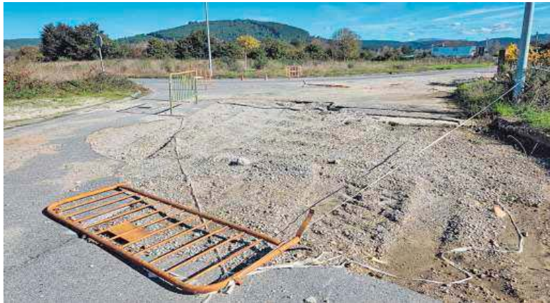
Señales de advertencia del corte parcial de la glorieta tiradas sobre la calzada. FOTOS CARLOS RUEDA
