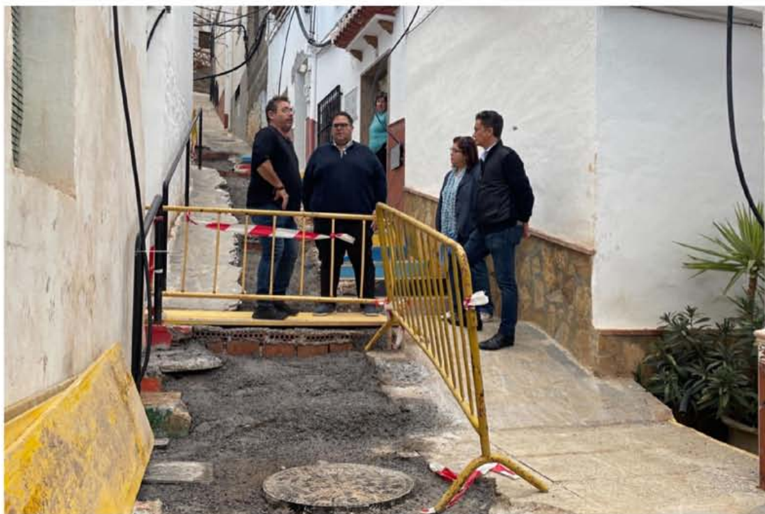
Las obras se están acometiendo en la calle Aguacate de Jete | Foto: Gabinete
